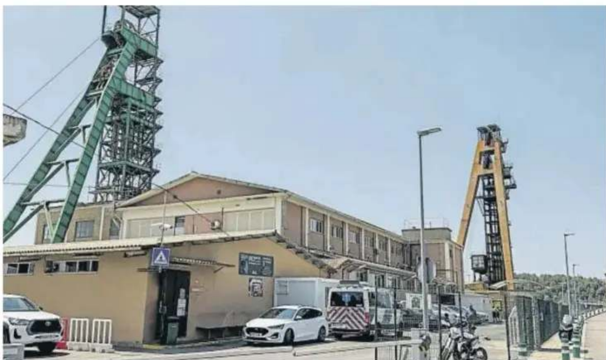
Instalaciones de la mina de Cabanasses, en Súrria (Barcelona)
